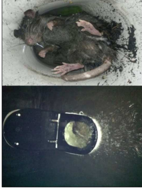
Kloak op gennem gulvfløb og toilet
